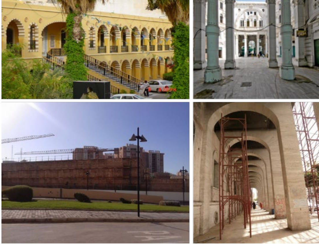
شكل (2) : مشاريع صيانة وتأهيل المباني التاريخية الموكلة بها جهاز تنمية وتطوير المدن . (المصدر : إدارة مشروعات المباني التاريخية بالجهاز).
