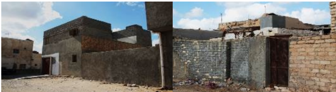
شكل (4) : بعض أعمال الترميم الأهلية. المدينة القديمة طرابلس.
