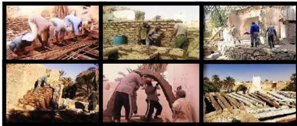
شكل رقم (10) صور مختلفة توضح المواد المحلية الصديقة للبيئة التي استخدمت في أعمال البناء وساهمت في العزل الحراري وتخفيض درجات الحرارة بشكل كبير داخل المدينة.
